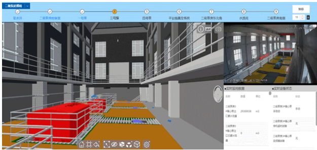
图2 水泵房自动巡检
